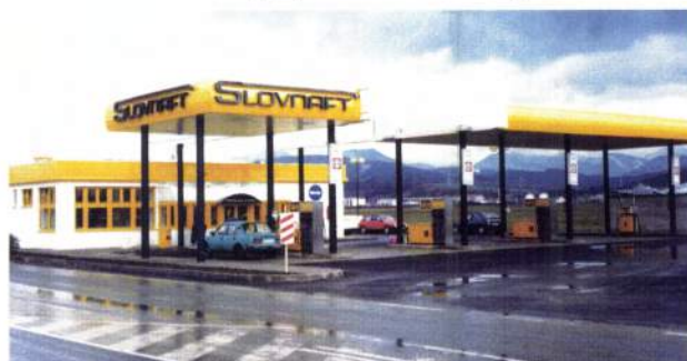
Moderná čerpacia stanica. Vďaka použitiu platní LEXAN (ktoré chránia zákazníka pred nepohodou počasia) pôsobí elegantným dojmom, ktorý akcentuje ľahkosť stavby (realizácia: TERCOMONT, spol. s r. o., Bratislava).
