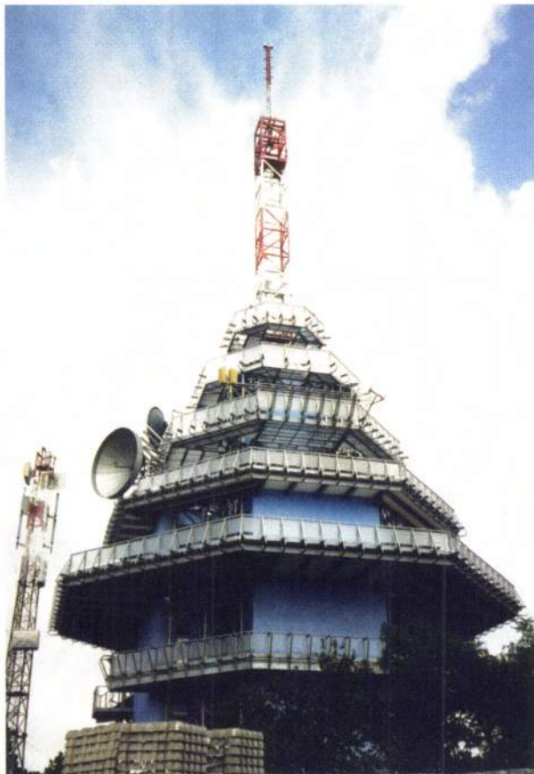
Ľahkosť konštrukcie sa skvele snúbi s bezpečnosťou - príklad využitia predností LEXAN-u na televíznom vysielacom v Nitre (realizácia: TERCOMONT, spol. s r. o. Bratislava)
