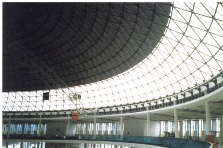
LEXAN-om presklená strecha najväčšieho pavilónu »Z« výstaviska BVV, a. s., v Brne.
