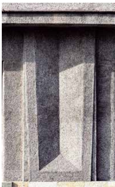
Obecný dom s úradovňami plynárenského a elektrického podniku v Hradci Královom, 1922 – 1923, detail geometrického pola v parterí. Foto: Jiří Zikmund
