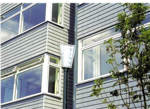
POULIČNÉ OSVETLENIE SO SOLÁRNymi KOLEKTORMI
