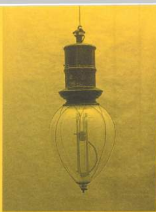
Závesná obličková lampa verejného osvetlenia na jednosmerný prúd, posledná štvrtina 19. storočia. Výrobca: B. Egger a spoločník.
