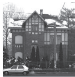
Vodárna Nová Ves
