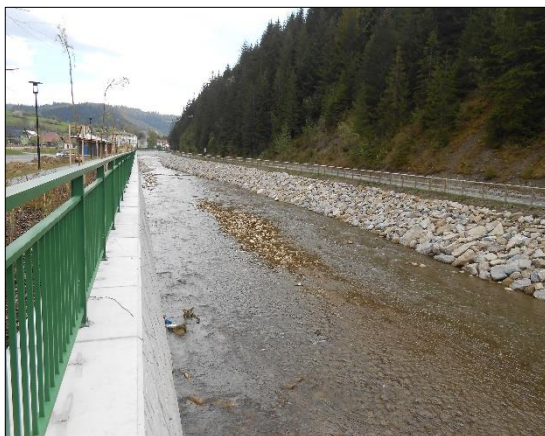
Obrázok 100: Zregulovaný úsek toku Bystrica, so zachovaným korytom a spevnenými brehmi, z ktorých bola odstránená brehová vegetácia (Autor: Maluniaková, 2016)
