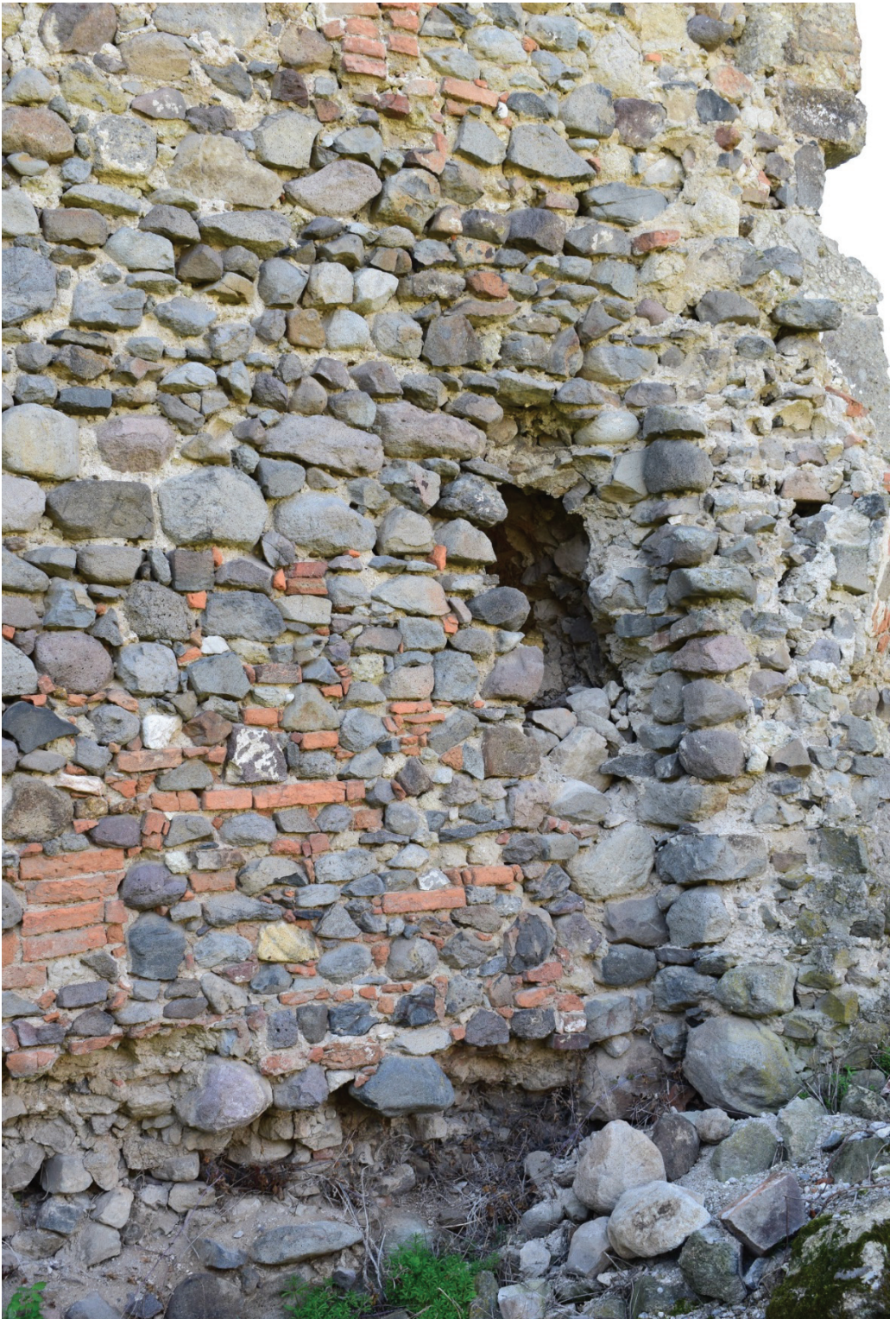
Obrázok 29 Detail zmiešaného muriva
