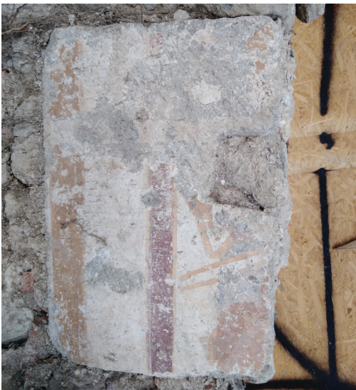
Obrázok 22 Fragment interiérovej nástennej maľby zo zaniknutého kláštorného kostola na kvádríku sekundárne použitom v murive západného krídla obytnej časti hradu.
