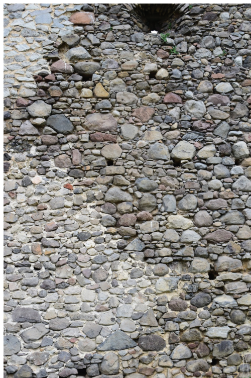
Obrázok 38 Vhodne realizovaná rekonštrukcia hradieb s rozlíšiteľnými doplnenými časťami od originálu
