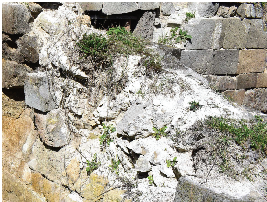
Obrázok 31 Detail novovekej malty
