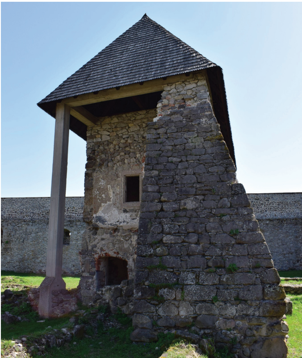
Obrázok 15 Kaplnka prestavaná z pôvodného gotického presbytéria kláštorného kostola
