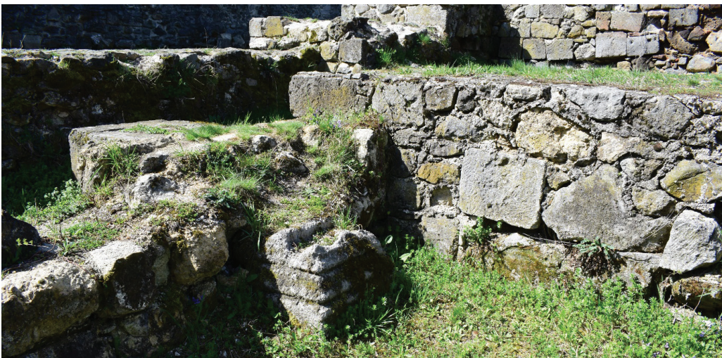
Obrázok 17 Pätky pilastra nesúceho krížovú klenbu kostola
