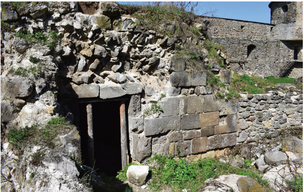
Obrázok 27 Kvádrikové murivo s jadrom murovaným v kláskovej väzbe v severnej veži kláštorného kostola
