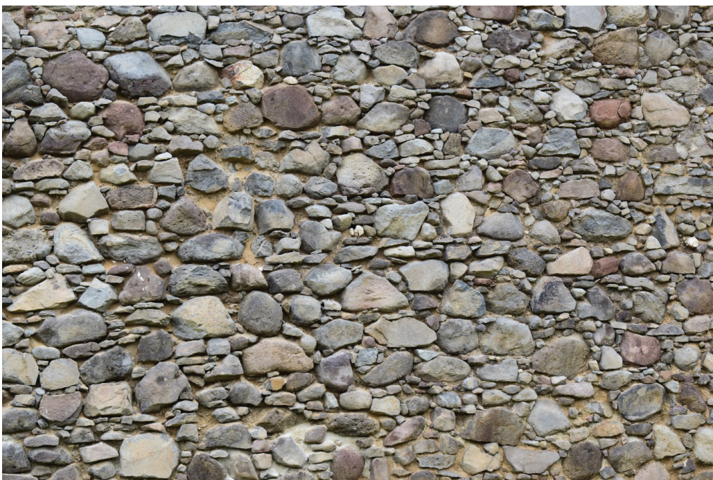
Obrázok 28 Riadkové murivo z lomového kameňa – najčastejší typ stavebnej štruktúry
