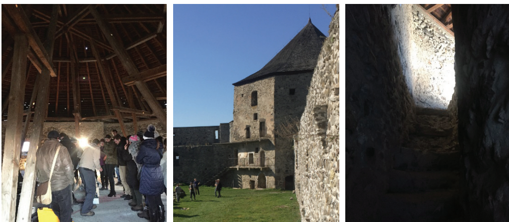
Obrázok 45 Obrázky zo vstupnej veže, kde predpokladáme vznik požiaru od elektroinštalácie.
