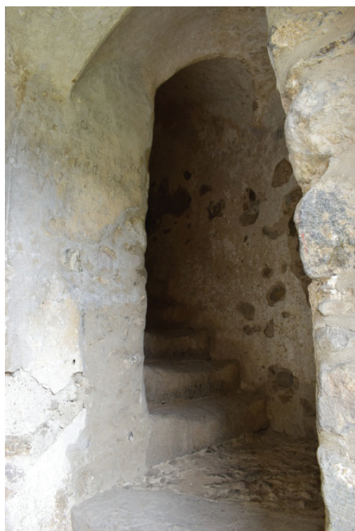
Obrázok 20 Severozápadná veža vnútorné schodisko v hmote muriva
